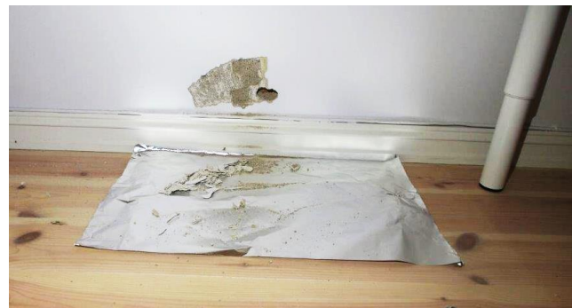
För att få pålitliga medelvärden analyserades stora bitar av det 4-5 mm tjocka spackellagret på flera platser i lägenheten
