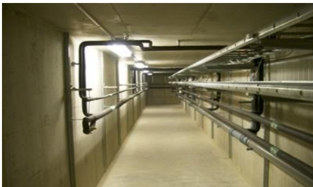
Markvärmväxlare i en Modern självdragsskola i form av en oisolerad kulvert under byggnaden. Vid sin passage genom kulverten värms tilluften av värme från marken vintertid och kyls av kylan i marken sommartid innan tilluften fortsätter upp och ventilerar lokalerna i byggnaden.
