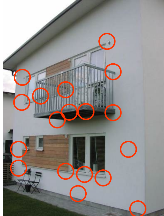
Känsliga detaljer på aktuell fasadkonstruktion
