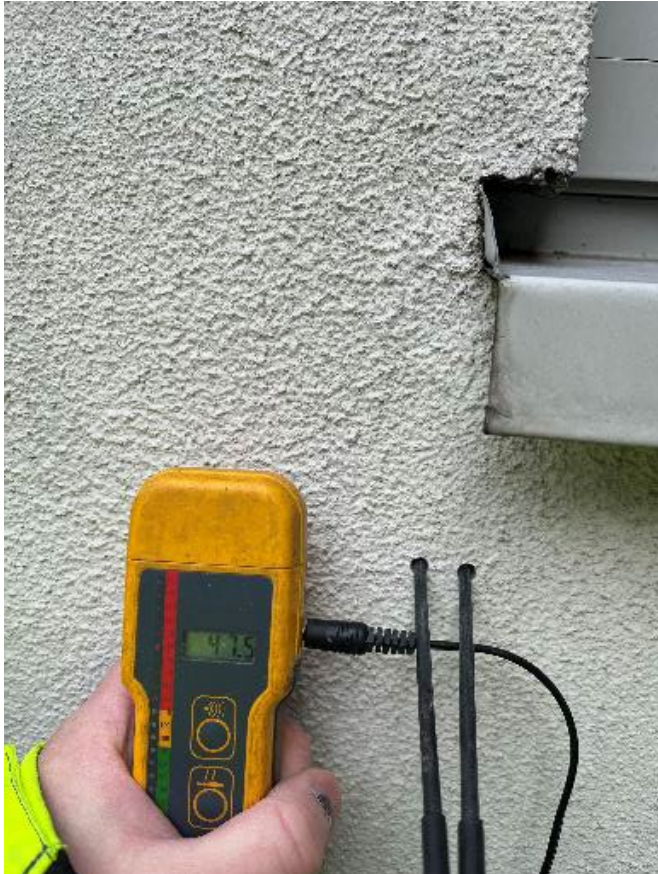
Fältmätning av fukt från utsidan
